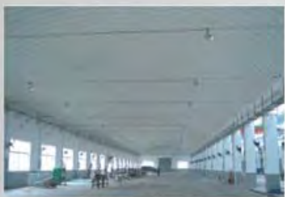
成型后的建筑物内景
