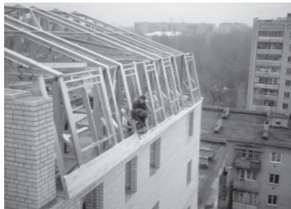
Рис. 4. Монтаж конструкций каркаса мансарды на 10-этажном доме в Саратове
