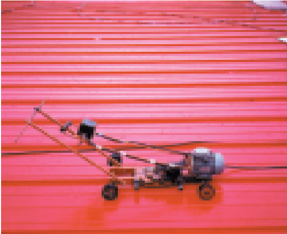
Рис. 9. Готовая кровля и фальцегибочная машинка для соединения кровельных листов между собой
