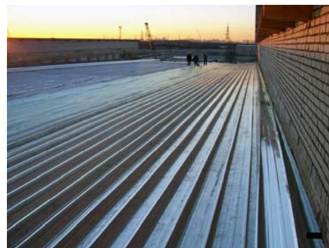
Монтаж П-образных панелей на кровле промышленного здания. Длина панелей без стыков - 67 метров!
