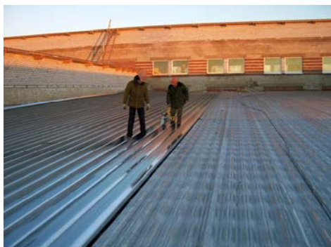
Монтаж П-образных панелей на кровле промышленного здания. Длина панелей без стыков - 67 метров!
