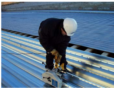
Монтаж П-образных панелей на кровле промышленного здания. Длина панелей без стыков - 67 метров!
